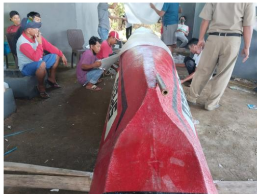
Gambar 7 Pelemuran Campuran Resin Dan Katalis Pada Roving 600
