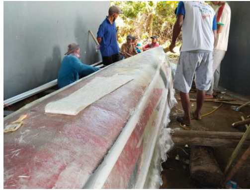
Gambar 9 Pemasangan Dan Pelemuran Tulangan Memanjang
