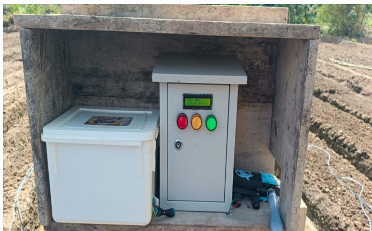
Gambar 3. Alat IoT yang Sudah Terpasang
